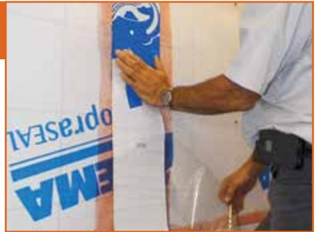
Recouvrir tous les joints des panneaux à l'aide d'une membrane SOPRASEAL STICK 1100 T ou SOPRASEAL STICK 600 TC en format découpe de 150 mm (6 po).
