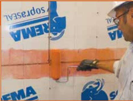
Imprégner d'APPRÊT SOPRASEAL STICK toutes les surfaces qui recevront la membrane autocollante afin de sceller les joints entre les panneaux.
