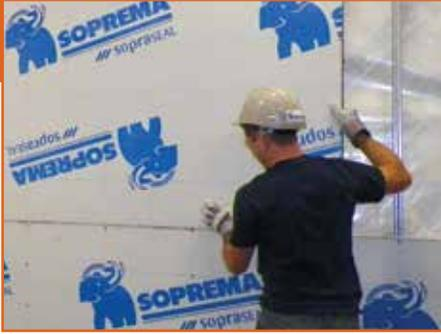
Installer les panneaux SOPRASEAL XPRESS G horizontalement sur les montants.
