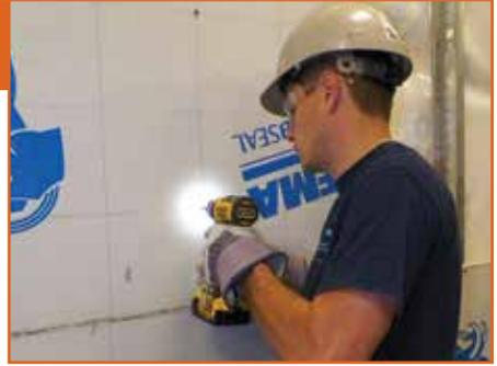
Fixer les panneaux à l'aide des VIS SOPRASEAL XPRESS G.
