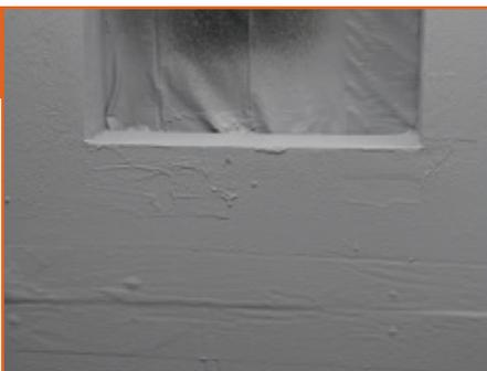
Laisser sécher complètement, généralement de deux à quatre heures (à 25 °C [77 °F] et à une humidité relative de 50 %).
