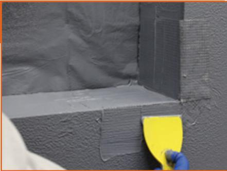
Installer SOPRASEAL MESH\* sur la couche encore humide et la saturer de SOPRASEAL LM 203.
