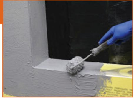
Appliquer une couche de SOPRASEAL LM 203 aux joints, aux ouvertures et aux détails.
