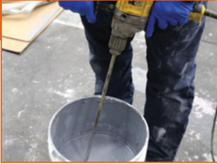
Mélanger le produit jusqu'à obtenir une consistance homogène. Pour une application à basse température (entre 4 °C et -4 °C), mélanger avec un contenant de SOPRASEAL LT ADDITIVE.
