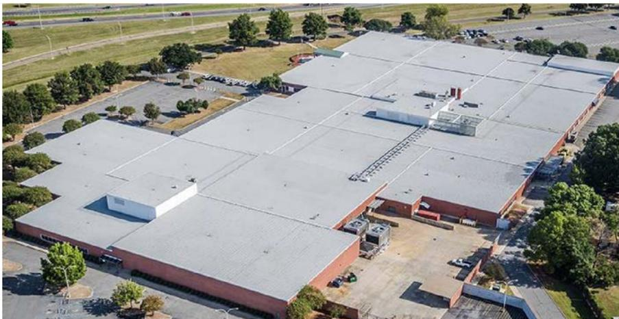
Membrane de toiture à faible pente installée à l'aide de bitume chaud et composée d'une membrane de finition et d'une membrane de sous-couche de bitume modifié au polymère SBS.
