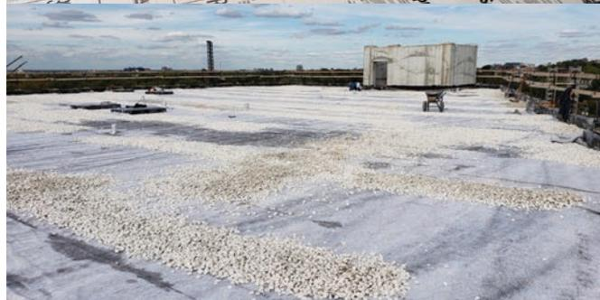
Le positionnement des panneaux de drainage, la disposition des panneaux isolants ainsi que le type et le poids du lest servant à maintenir les isolants en place sont aussi des éléments importants à considérer.
