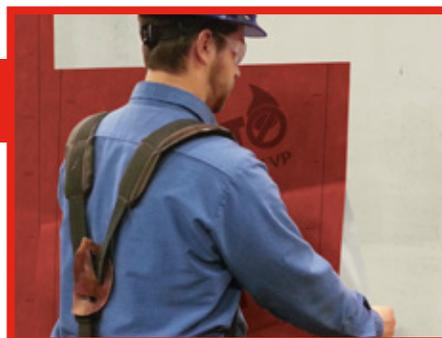
Retirer graduellement le film siliconé détachable, tout en s'assurant que la membrane est complètement adhérente afin d'éviter les poches d'air et les plis.
