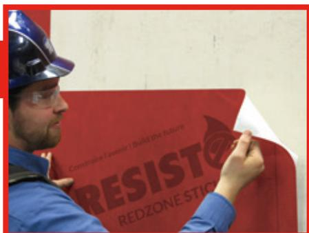
Retirer la partie supérieure du film siliconé détachable et adhérer la membrane, en prenant soin de bien l'aligner.
