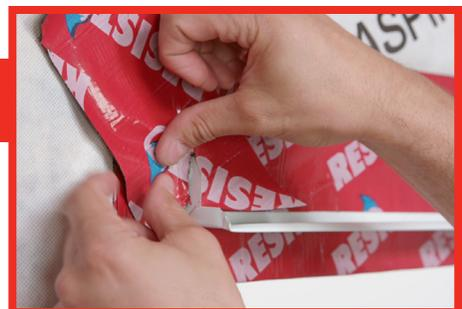
Sceller les coins du solin métallique en installant une bande REDZONE de façon oblique sur chaque extrémité.
