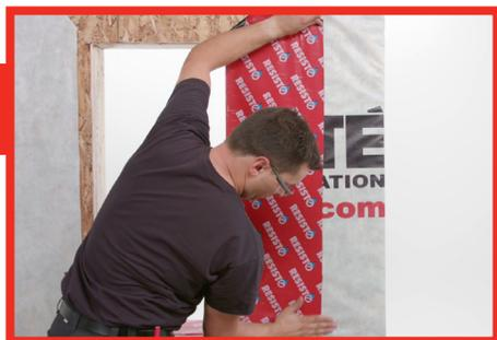
Installer une bande de membrane REDZONE à partir d'environ 5 à 7,5 cm (2 à 3 po) sur le pare-intempérie de la solive.
