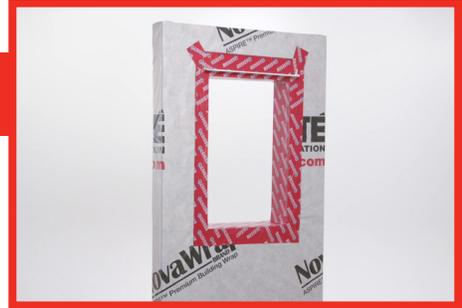
Insérer la fenêtre dans l'ouverture en faisant adhérer la partie de la membrane supérieure dépassant dans l'ouverture.
