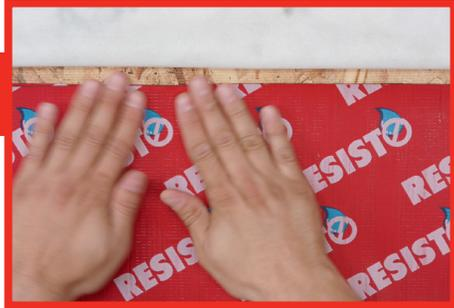
Relever le pare-intempérie du haut. Adhérer une bande REDZONE pour couvrir la partie supérieure de la fenêtre. La membrane doit être assez large pour dépasser d'environ 2.5 cm (1 po) dans l'ouverture.
