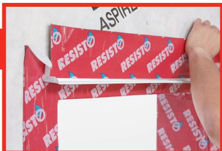
Appliquer une bande REDZONE sur le pare-intempérie et le solin métallique de façon à assurer la continuité du pare-air.
