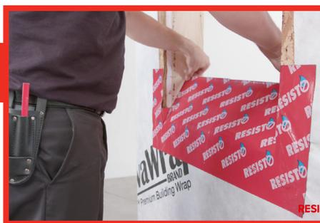
Appliquer une bande REDZONE sur la partie inférieure de la fenêtre en couvrant environ 5 à 7,5 cm (2 à 3 po) du pare-intempérie. Couper la membrane de chaque côté de l'ouverture et faire adhérer la membrane à l'aide d'un rouleau maroufleur.
