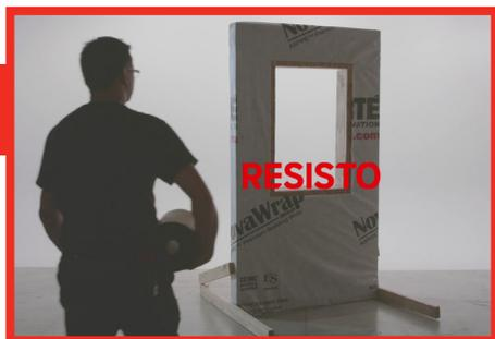
Fixer le pare-intempérie de manière à couvrir le seuil et les montants. Couper ensuite le pare-intempérie sur une largeur d'environ 6 cm (2 po) de tous les côtés du seuil de la fenêtre.
