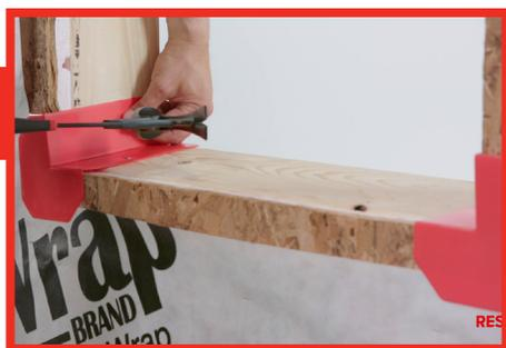
Fixer mécaniquement les coins protecteurs REDZONE en place.
