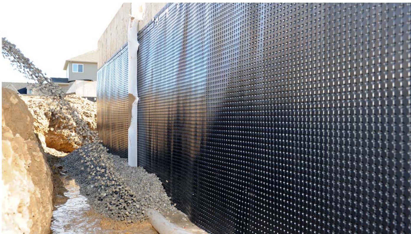
REMBLAYAGE PAR-DESSUS LE DRAIN DE SEMELLE
