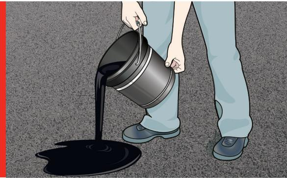
Enduit d'émulsion à base d'eau et de brai de houille utilisé pour prévenir les fissures et la détérioration des pavés asphaltés causées par l'usure, le gel, les déversements d'huile et d'essence, le sel, le soleil et la pluie.
