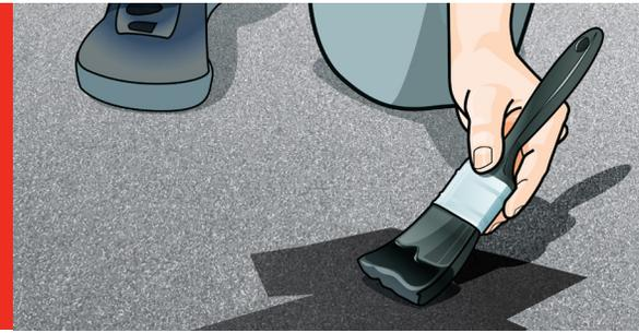
L'APPRÊT POUR TACHES D'HUILE est un enduit d'imprégnation aux polymères servant à augmenter l'adhérence des enduits de protection d'asphalte sur les surfaces altérées par des dépôts d'huile.
