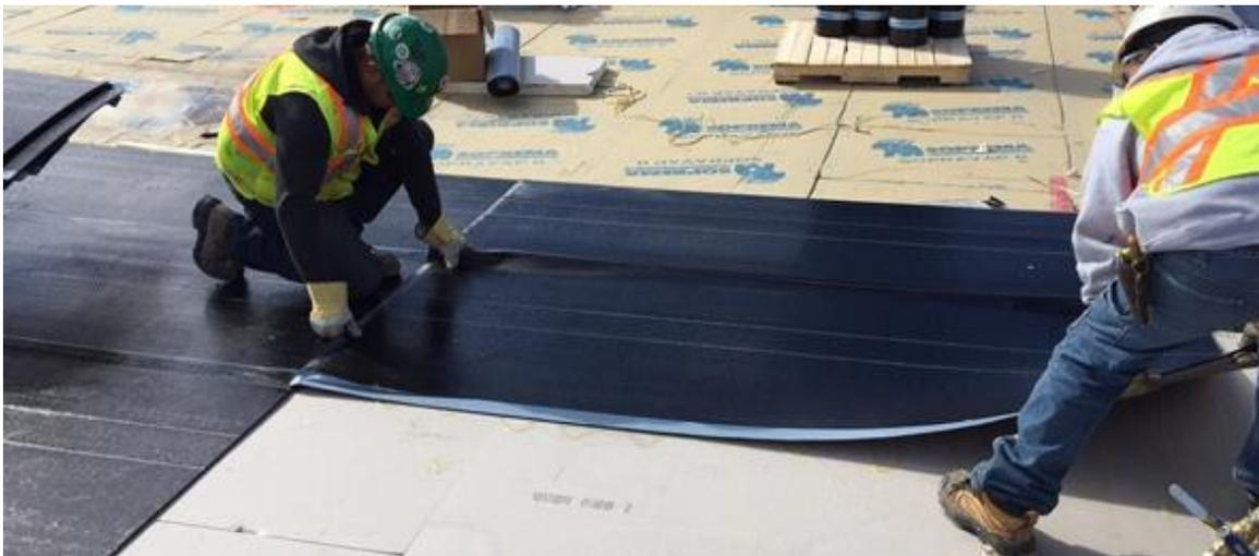
Figure 2 : Installation d'une membrane de sous-couche au bitume modifié au SBS en panneaux
