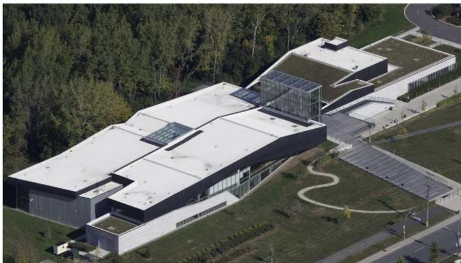
Membrane de toiture à faible pente en panneaux composée d'une membrane de finition et d'une membrane de sous-couche en panneaux de bitume modifié au polymère SBS.
