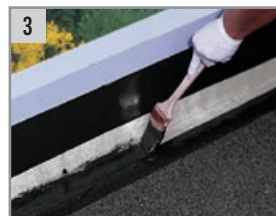
3 Aplicar una primera capa de ALSAN FLASHING de 0.9 kg/m 2 sobre el TEXTIL A 100.
