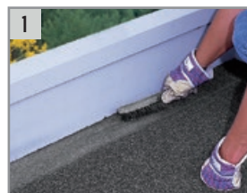
1 Remover la gravilla suelta de las membranas existentes con un cepillo metálico.
