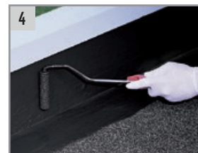
4 Después de 2 - 5 h aplicar la segunda capa de ALSAN FLASHING de 0.7 kg/m 2 sobre la primera capa.
