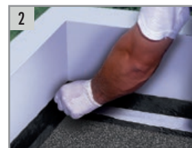
2 Colocar el TEXTIL A 100 sobre una ligera capa (húmeda) de ALSAN FLASHING de 0.5 kg/m 2 .
