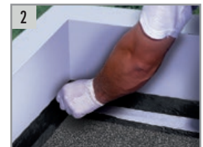
2 Colocar el TEXTIL A 100 sobre una ligera capa (húmeda) de ALSAN FLASHING de 0.5 kg/m 2 .
