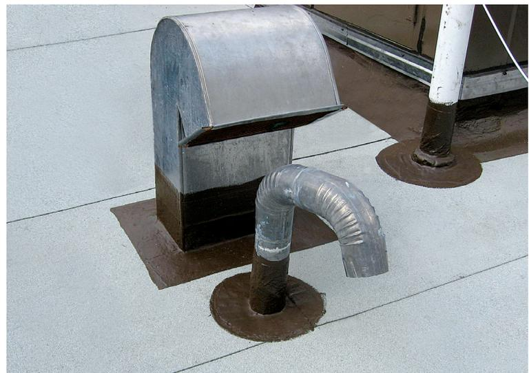
De plus, l'ALSAN FLASHING WINTER offre la même performance que la version standard, mais pour une application à basse température (jusqu'à -10 °C sans conditionnement). Bi-composant, il est offert en deux parties dans une boîte pour un volume total de 3,37 litres.
