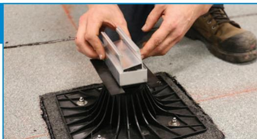
Insérer les rehausses et le bloqueur de rehausse sur le plot.
