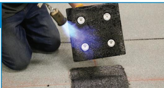
Chauffer la pellicule de plastique de la sous-face du plot à l'aide d'un chalumeau au propane.
