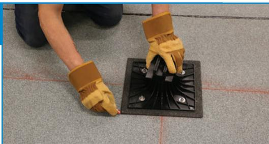
Une fois que l'installation de la membrane de finition sur la toiture est terminée, marquer l'emplacement du PLOT SOPRASOLAR FIX EVO TILT sur la membrane de finition selon le schéma fourni par l'entrepreneur responsable des panneaux photovoltaïques.
