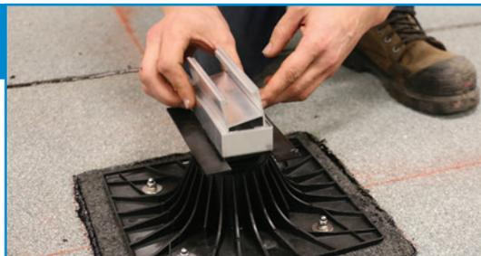
Insérer les rehausse et le bloqueur de rehausse sur le plot.
