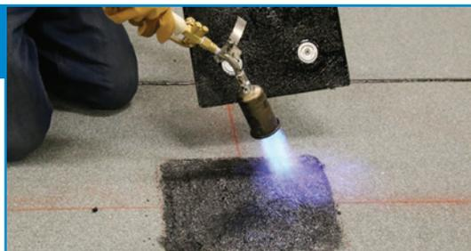
Chauffer la zone où sera installé le plot à l'aide d'un chalumeau au propane.
