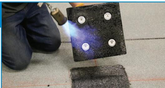
Chauffer la pellicule de plastique de la sous-face du plot à l'aide d'un chalumeau au propane.
