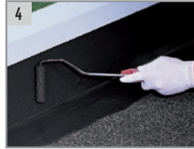
4 Después de 2 - 5 h aplicar la segunda capa de ALSAN FLASHING de 0.7 kg/m 2 sobre la primer capa.
