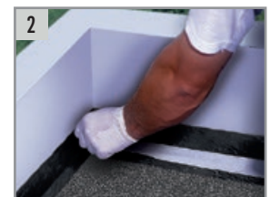
2 Colocar el ARMATURE FLASHING sobre una ligera capa (húmeda) de ALSAN FLASHING de 0.5 kg/m 2 .
