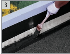
3 Aplicar una primera capa de ALSAN FLASHING de 0.9 kg/m 2 sobre el ARMATURE FLASHING.
