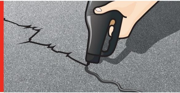
L'enduit de colmatage de fissures RESISTO est conçu pour colmater les petites fissures et joints des surfaces asphaltées. Il prévient la détérioration des pavés d'asphalte causée par l'usure, la pluie et le gel.
