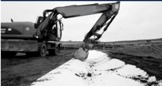
5. Dependiendo de la temperatura exterior y la cantidad de agua utilizada para la hidratación, Tiltex® necesita un mínimo de 24 horas para endurecerse y estar listo para su uso.
