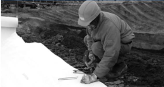
3. Se recomienda una superposición de 10 a 20 cm según la aplicación. En el caso de que Tiltex® se use para el control de la erosión, la superposición se organiza en mosaicos.
