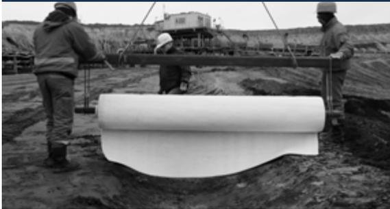
2. Los rollos anchos Tiltex® deben desplegarse utilizando elementos de elevación adecuados y una viga de elevación.
