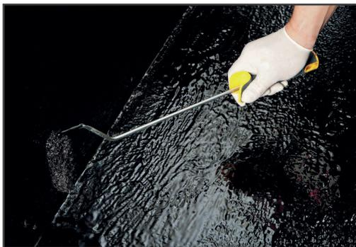
Nota: El secado del **ALSAN FLASHING** tendrá una variación dependiendo de la temperatura ambiente. En zonas con temperatura de 30°C tardará 2 horas, por otro lado, si se considera una temperatura de 20°C tardará 3 horas o en el caso de una temperatura de 5°C el secado será hasta las 18 hrs.
