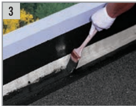
3 Aplicar una primera capa de ALSAN FLASHING JARDIN de 0.9 kg/m 2 sobre el TEXTIL A 100.
