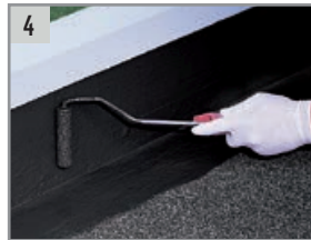
4 Después de 2 - 5 h aplicar la segunda capa de ALSAN FLASHING JARDIN de 0.7 kg/m 2 sobre la primer capa.
