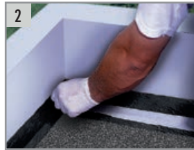
2 Colocar el TEXTIL A 100 sobre una ligera capa (húmeda) de ALSAN FLASHING JARDIN de 0.5 kg/m 2 .
