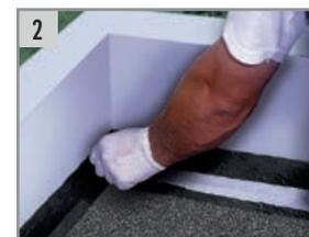
Colocar el TEXTIL A 100 sobre una ligera capa (húmeda) de ALSAN FLASHING de 0.5 kg/m<sup>2</sup>.
