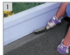
Remover la gravilla suelta de las membranas existentes con un cepillo metálico.
