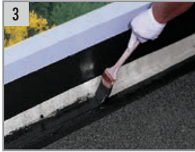
3 Aplicar una primera capa de ALSAN FLASHING de 0.9 kg/m 2 sobre el TEXTIL A 100.
