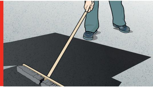
Enduit à base d'émulsion aqueuse et de bitume utilisé pour prévenir les fissures et la détérioration des pavés asphaltés causées par l'usure, le gel, les déversements d'huile et d'essence, le sel, le soleil et la pluie.
