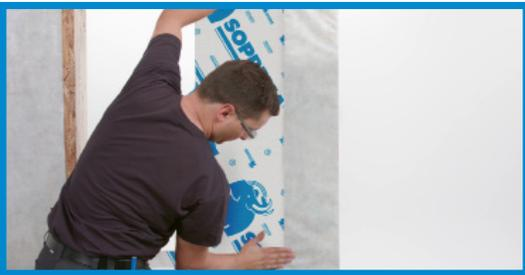
Installer une bande de membrane d'environ 5 à 7,5 cm (2 à 3 po) sur le pare-intempérie.
