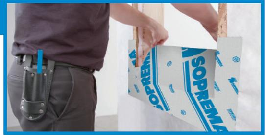
Appliquer la membrane SOPRASEAL STICK AVB AT sur la partie inférieure de la fenêtre et couvrir 5 cm à 7,5 cm (2 po à 3 po) du pare intempérie.
