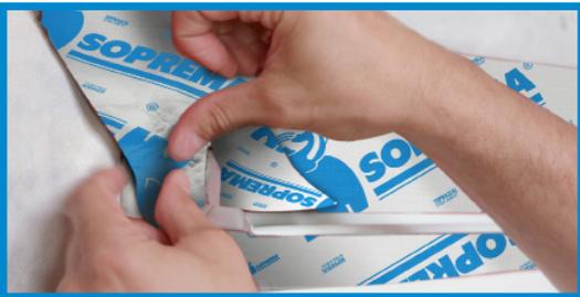
Sceller les coins du solin métallique avec la membrane SOPRASEAL STICK AVB AT en diagonale à chaque extrémité.
